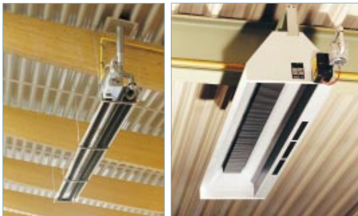
Dunkelstrahler werden in unterschiedlichen Ausführungen angeboten – z.B. mit U-förmigem Strahlungsrohr (links), mit Konverter (Mitte) oder mit mehreren Brenneinheiten und Sammelabgasventilator
