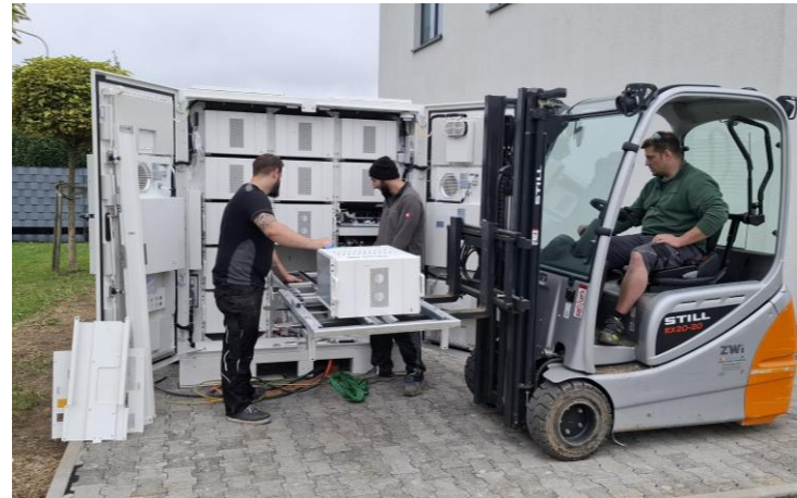
Aufbau des ersten Speichers
