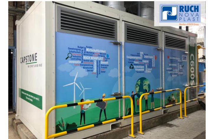
MGT Hocheffiziente Dampferzeugung mit Turbinenabgas
