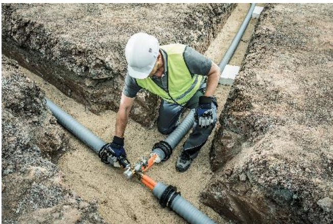
Abbildung 1: Verlegung eines Nahwärmenetzes. Bild: REHAU AG + Co
